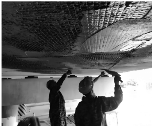
混凝土破损修复
