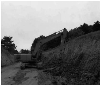
挖掘机开挖路基
