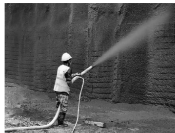
混凝土喷射
