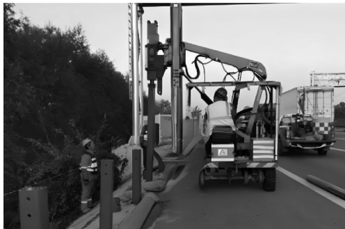
波形护栏拆除、更换
