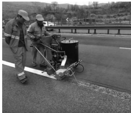
热熔标线施工
