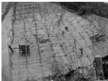
混凝土护坡施工
