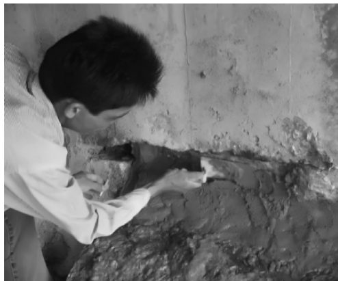
混凝土破损修复
