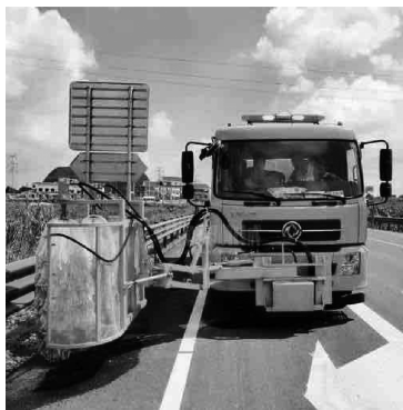
机械清洗波形钢板护栏
