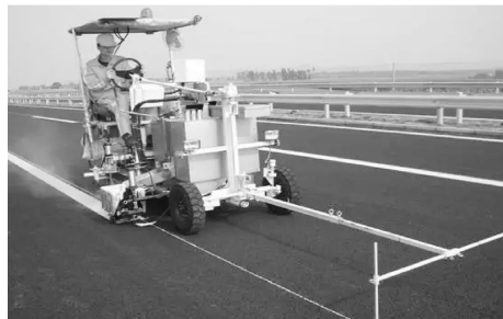
振动标线施工
