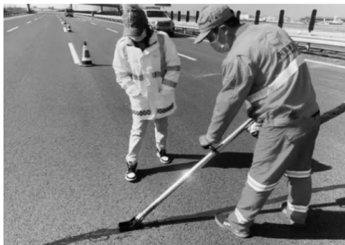
处理沥青混凝土路面裂缝
