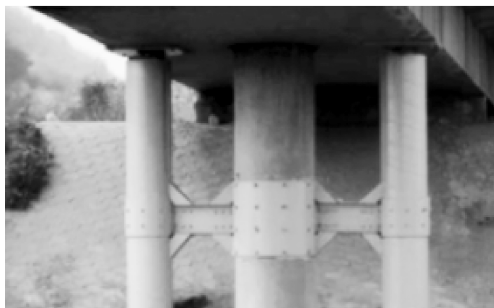
新增钢管柱混凝土加固
