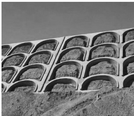
现浇混凝土框格式护坡
