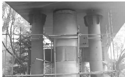
新增钢管柱混凝土加固
