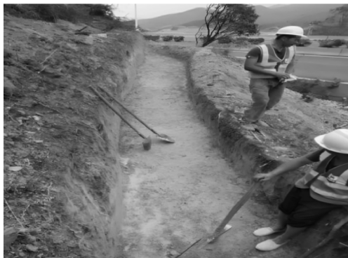
人工开挖沟槽
