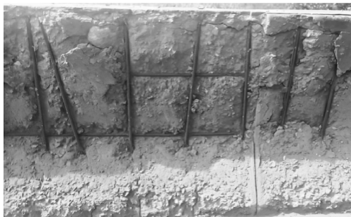
钢筋混凝土护栏病害
