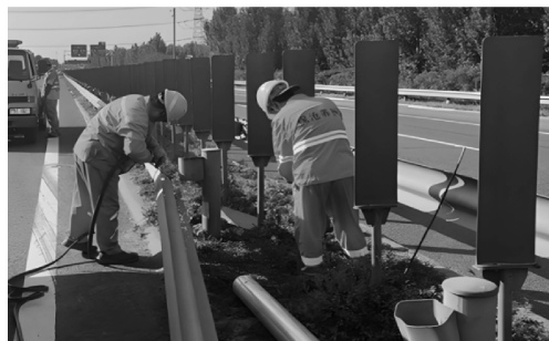
波形护栏维修、更换
