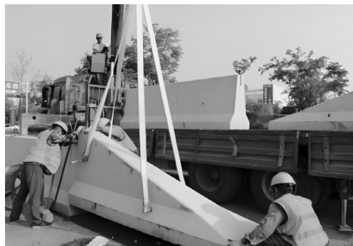
混凝土护栏运输、安装
