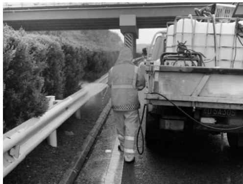
人工清洗波形钢板护栏
