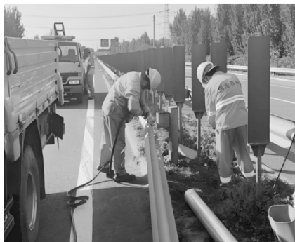
波形梁护栏施工
