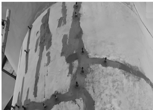
桥梁裂缝处理
