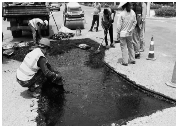
处理沥青混凝土路面坑槽
