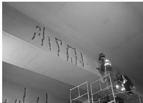
桥梁裂缝处理
