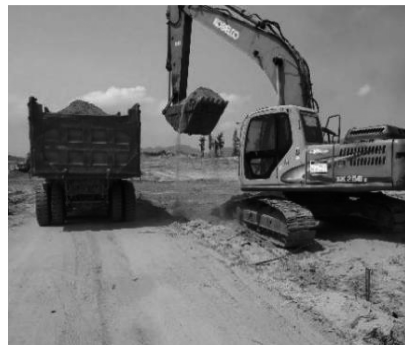
挖掘机挖装土方
