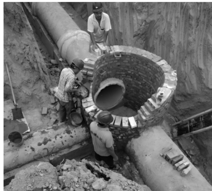
雨水井、检查井(尺寸单位:mm)
