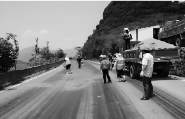
处理沥青混凝土路面泛油
