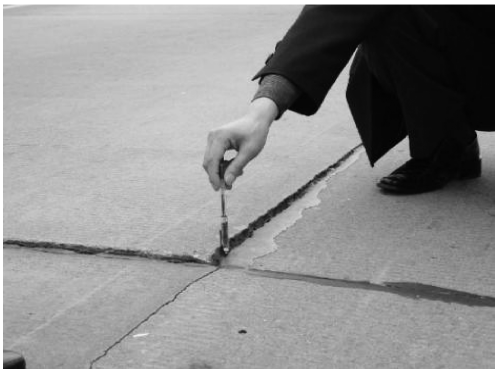
水泥混凝土路面错台
