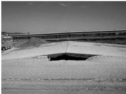
水泥混凝土路面拱起
