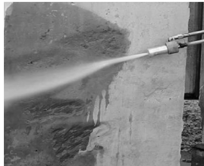
高压水力破除
