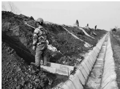
人工开挖沟槽
