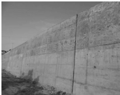
现浇混凝土挡土墙
