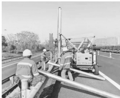
波形梁护栏施工
