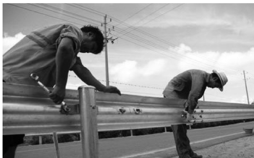
波形护栏维修、更换
